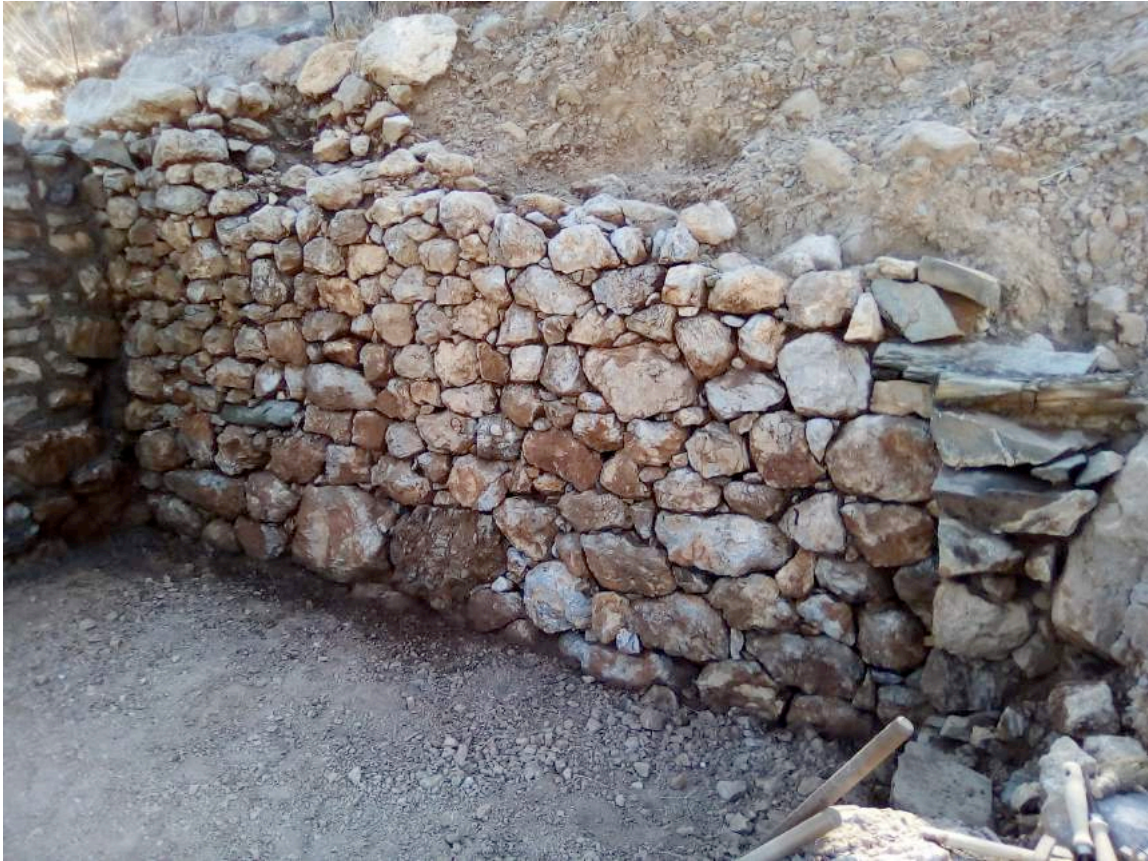
Εικ. 7. Καθαρισμός τοιχοποιίας D1703 (στο D1700) για την προετοιμασία της αρμολόγησης
