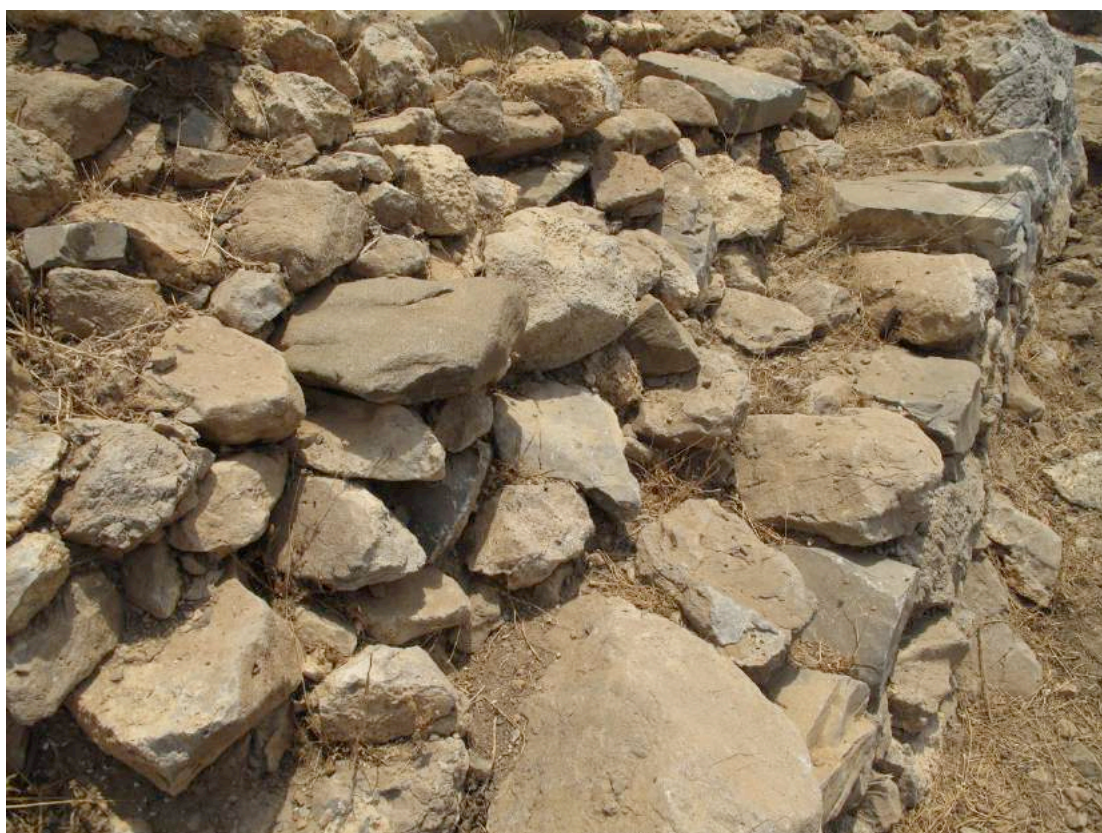
Εικ. 3. Αναλημματικό τοιχίο D2002, με λιθορριπή λατύπων και λίθων μεσαίου και μεγάλου μεγέθους, πίσω από αυτό, τυπικό δείγμα της Αρχαϊκής Εποχής
