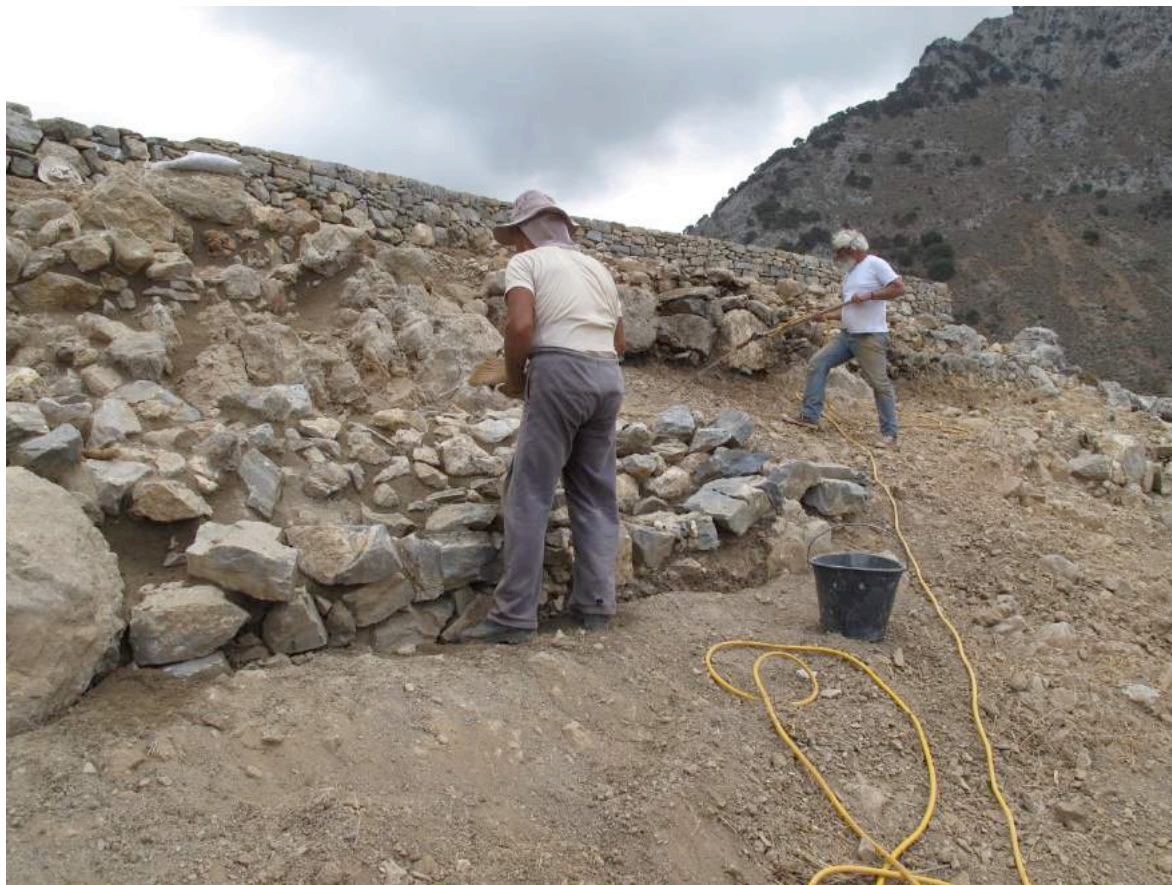
Εικ. 12. Στερέωση αναλημματικών τοιχίων D2400 και D2402
