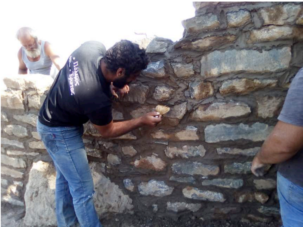
Εικ. 6. Τοιχοποιία D1621 (στο D1700) κατά τη διάρκεια της συντήρησης
