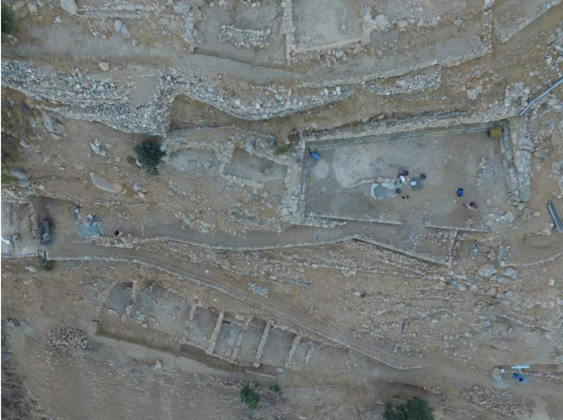
Εικ. 16. Γενική άποψη των εργασιών επίστρωσης δαπέδων
