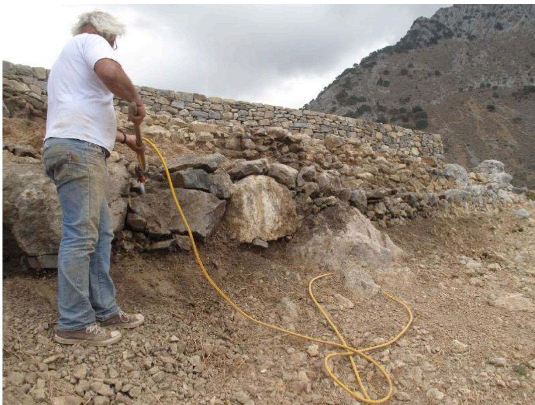
Εικ. 2. Αναλημματικά τοιχία με ογκόλιθους και λιθορριπή λίθων και λατύπων.
