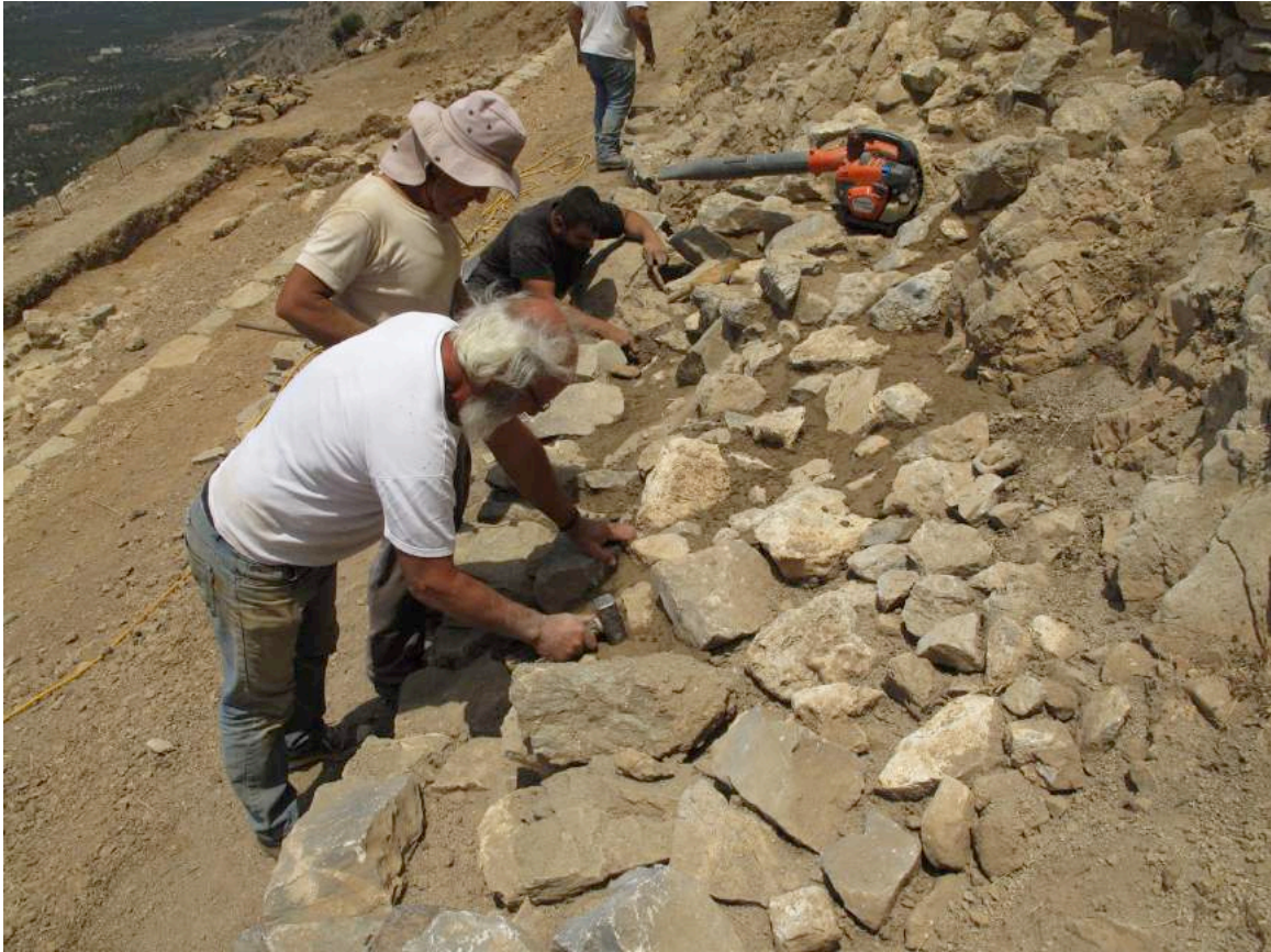
Εικ. 13. Στερέωση αναλημματικού τοιχίου και λιθορριπής (D2402)
