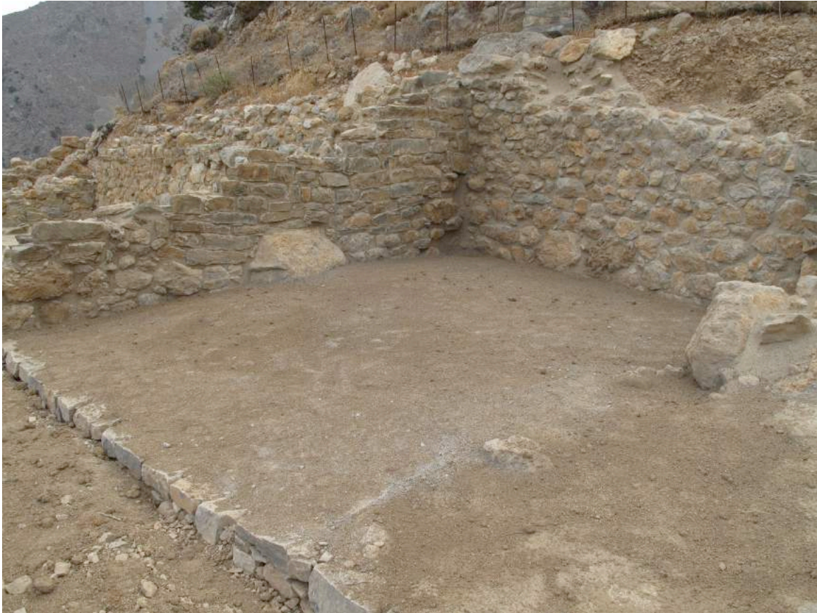
Εικ. 9. Τοιχοποιίες D1621 και D 1703, στο D1700, μετά τη συντήρηση
