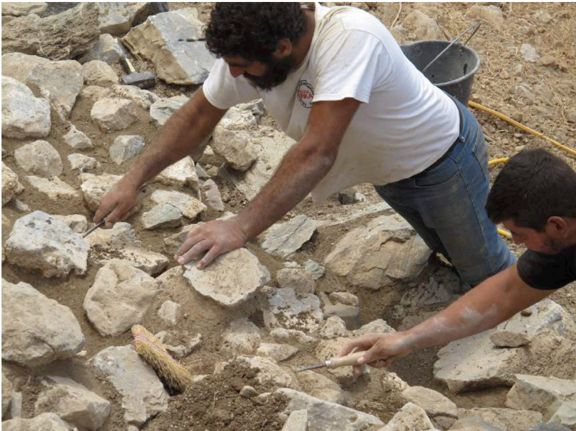
Εικ 14 Στερέωση λιθορριπής πίσω από το αναλημματικό τοίχιο D2402
