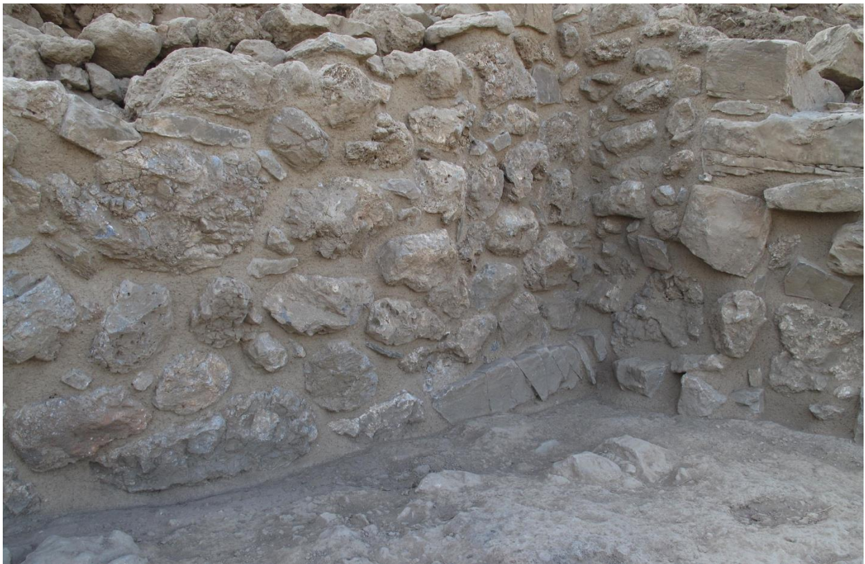
Εικ. 7: Τομέας B5800, λεπτομέρεια της Ανατολικής τοιχοποιίας μετά τη στερέωση
