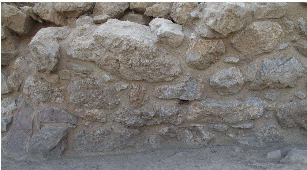
Εικ. 2-3: Τομέας B5800, Ανατολική τοιχοποιία μετά τον καθαρισμό (πάνω) και μετά την στερέωση (κάτω).
