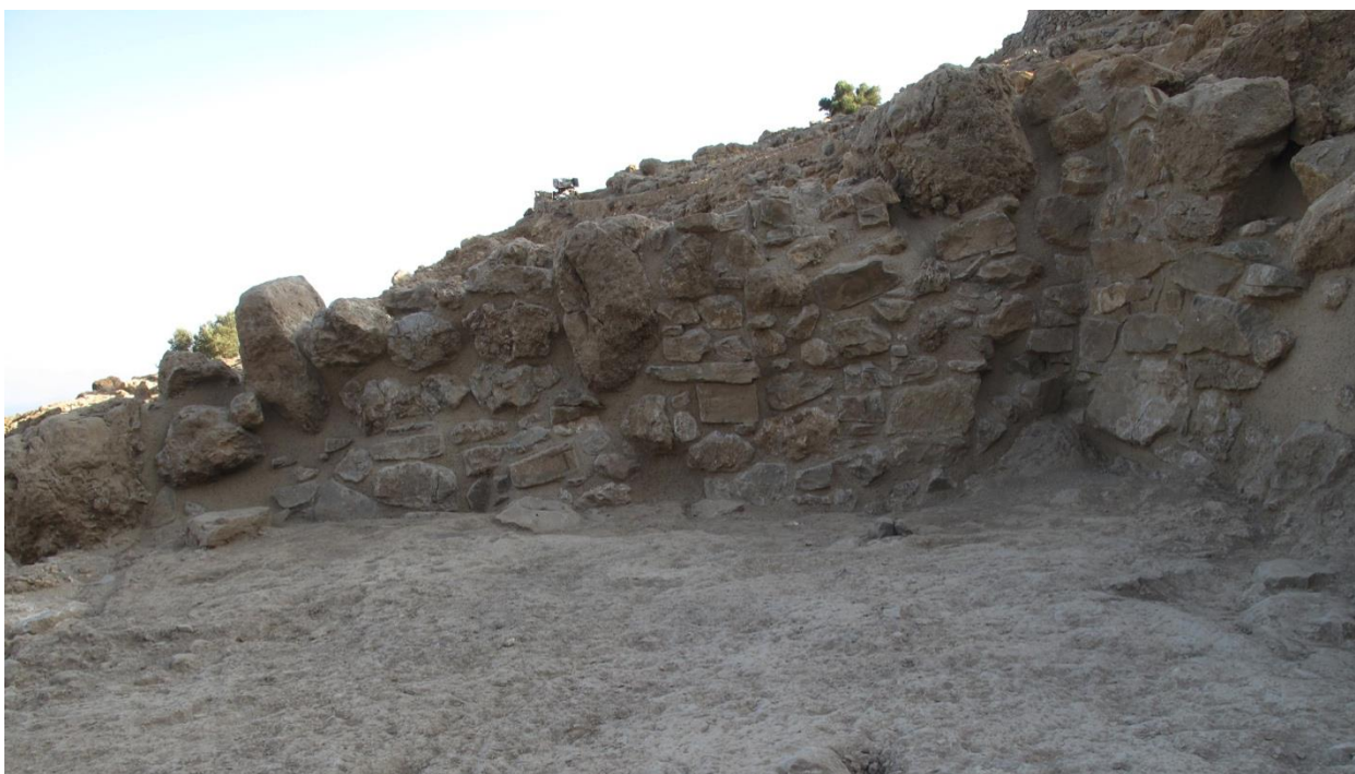
Εικ. 9: Τομέας Β5800, γενική άποψη της Βόρειας τοιχοποιίας μετά τη στερέωση
