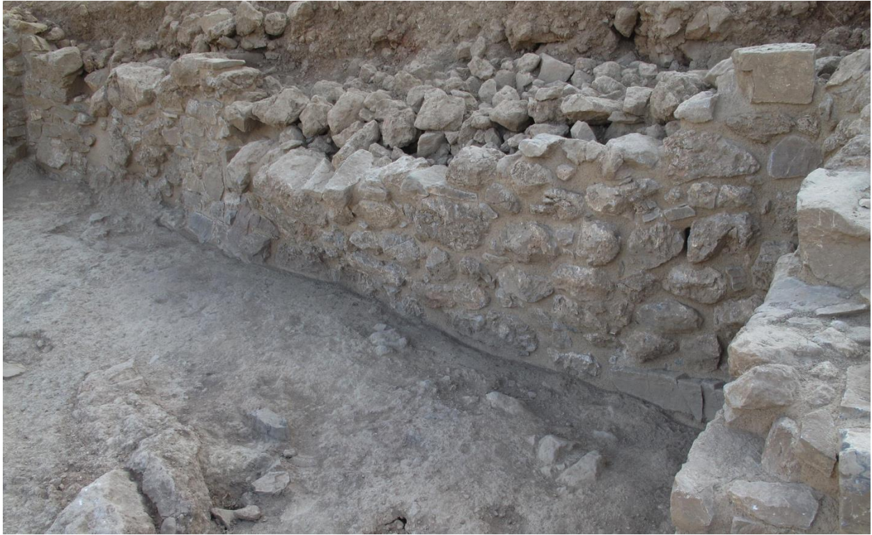
Εικ. 6: Τομέας B5800, γενική άποψη της Ανατολικής τοιχοποιίας μετά τη στερέωση
