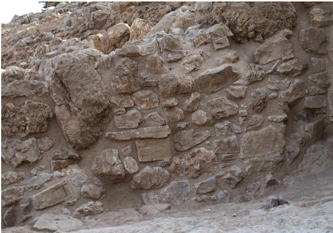
Εικ. 11: Τομέας Β5800, λεπτομέρεια της Βόρειας τοιχοποιίας μετά τη στερέωση
