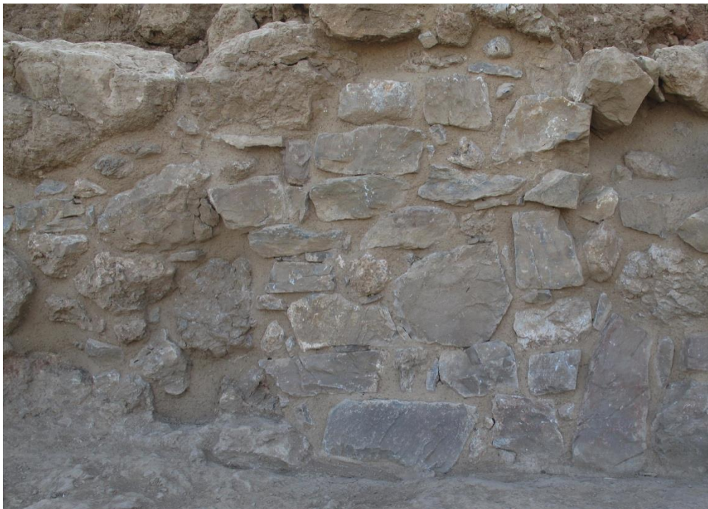
Εικ. 5: Τομέας B5800, Βόρειο τμήμα της Ανατολικής τοιχοποιίας μετά τη στερέωση
