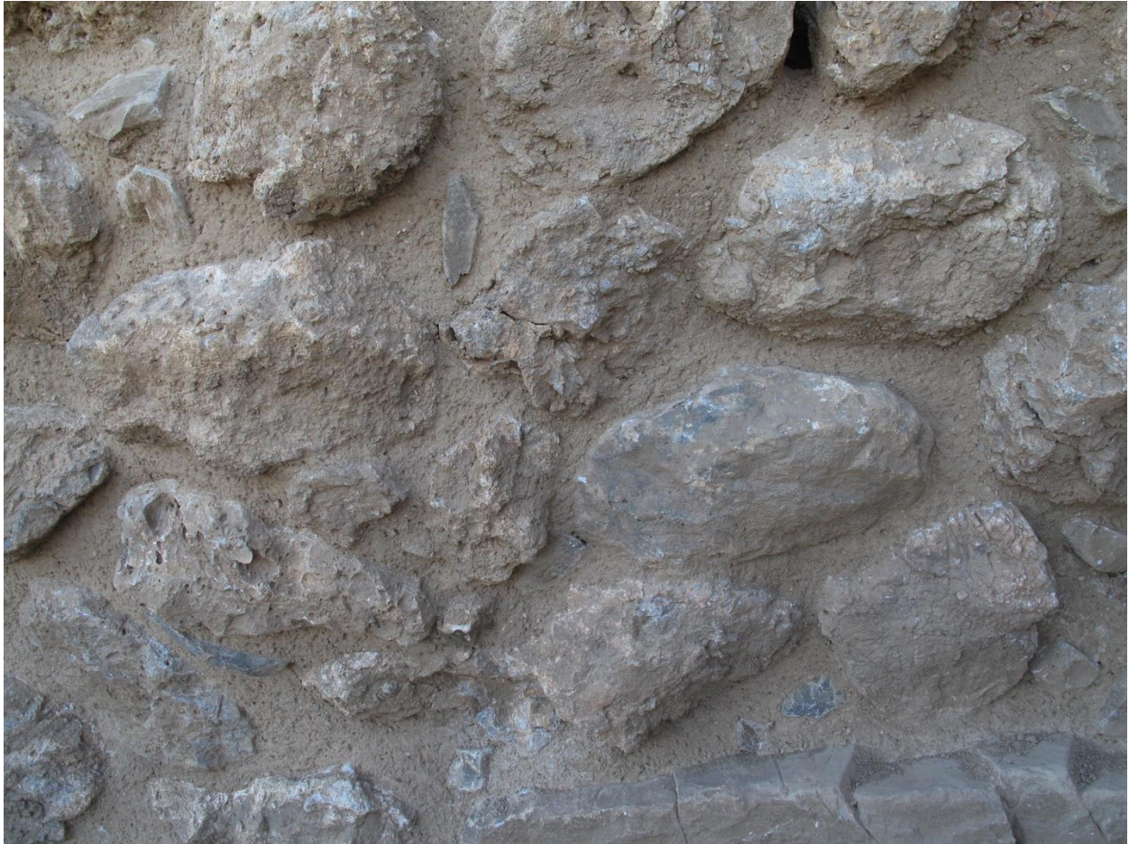
Εικ. 1. Εφαρμογή αργιλοκονιάματος αρμολόγησης, 2016, Τομέας Β5800
