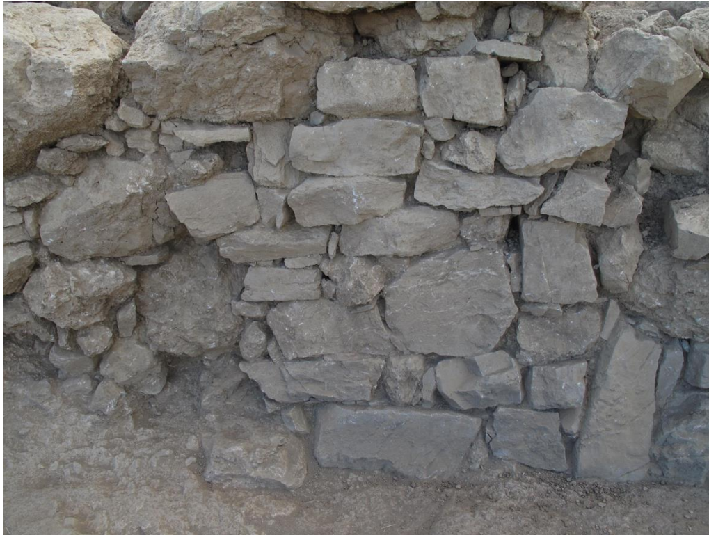
Εικ. 4: Τομέας B5800, Βόρειο τμήμα της Ανατολικής τοιχοποιίας μετά τον καθαρισμό και πριν τη στερέωση
